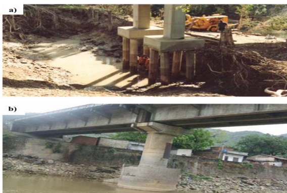
شکل ۲- الف) آبشستگی اطراف پایه‌های پل در رودخانه لوگان، استرالیا ب) آبشستگی اطراف پایه‌های پل در رودخانه تینانو، نپال (Shrestha, 2015)
