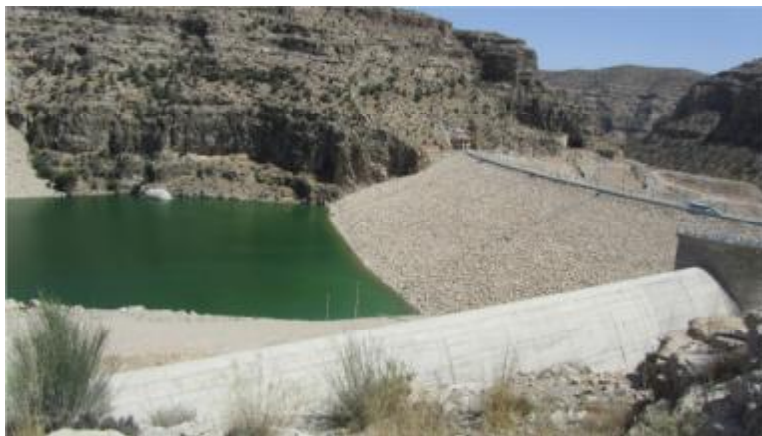
شکل ۱- نمایی از تکیه‌گاه چپ سد تنگاب
