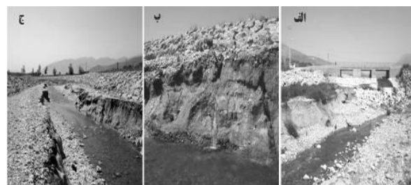
شکل ۲- نمایی از وضعیت رودخانه: الف) پل عیسی‌آباد، ب) پدیده تراوش و ج) رسوبات حساس به فرسایش
