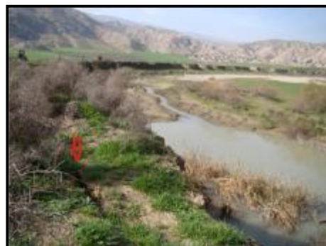
شکل ۱- فرسایش سواحل رودخانه‌ها (رودخانه سیمره - شهرستان سیروان)
